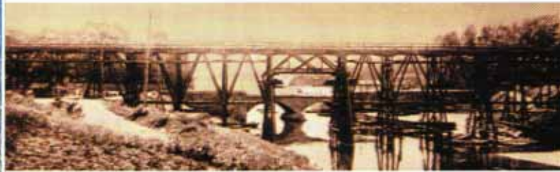
Jernbanebroen ved Lysaker bygget i tre omkring 1900-tallet
